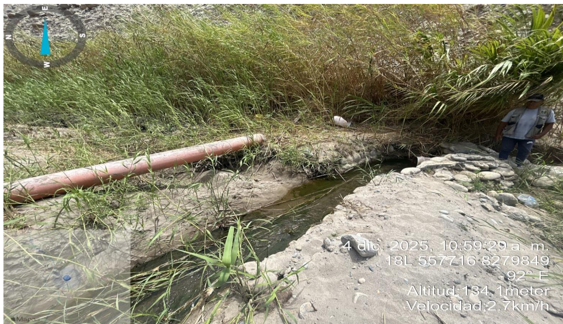
FIGURA N°03: TRANSICION DE CANAL DE TIERRA A TUBERIA PVC PARA LLEVAR AGUA AL SECTOR LAMPILLA, MARGEN IZQUIERDA, SECTOR LAMPILLA, DISTRITO DE JAQUI, PROVINCIA DE CARAVELI, DEPARTAMENTO DE AREQUIPA
